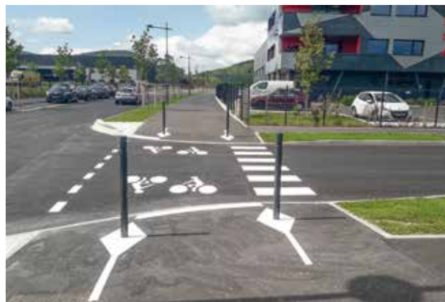
Aménagement du PA Bièvre Dauphine 2
