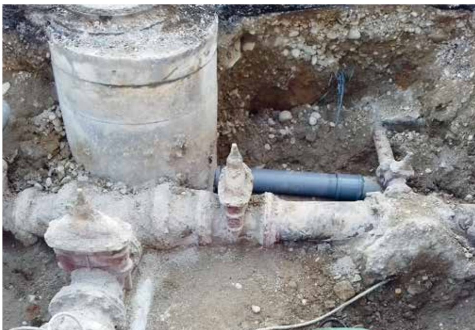
Conduite eau potable avant intervention (réseau années 60)
